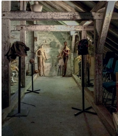
Dachboden der Designschule Schwerin
